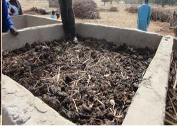
Photo 7 : étalage de la couche de fumier
