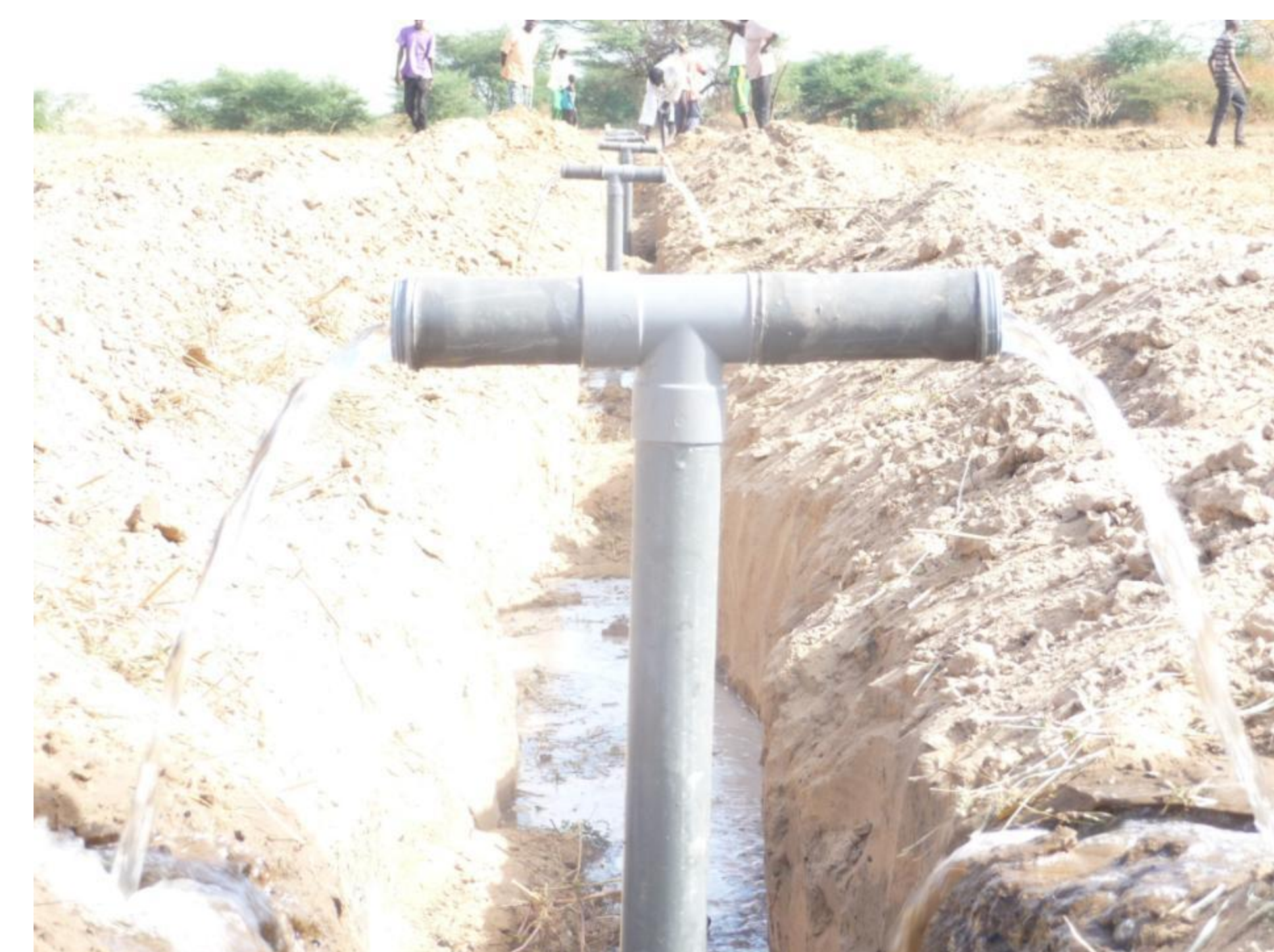
Fig. 5- Installation et test du réseau d'irrigation
