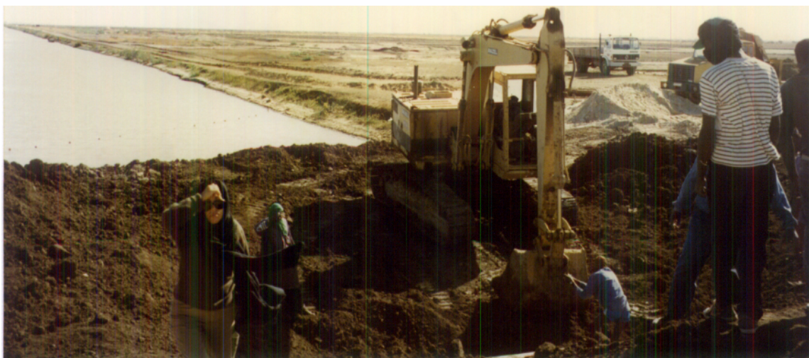
PHOTO N° 2 -- TRAVAUX D'EXTENSION DES CANAUX D'IRRIGATION DANS LA ZONE AMÉNAGÉE DE LA SONADER A ROSSO, (DELTA DU FLEWE SENEGAL), MAURITANIE.
