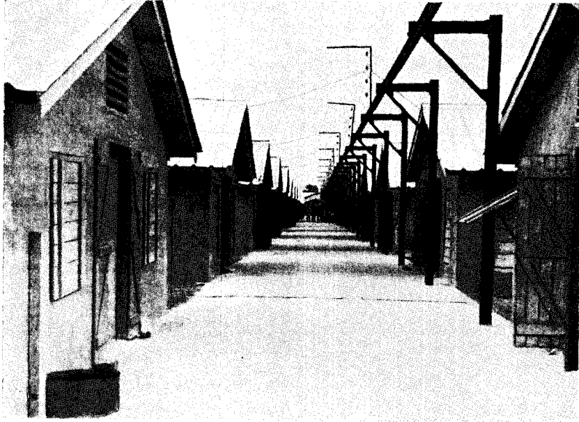
Fig. III. — Les bâtiments abritant les batteries d'élevage (remarquer le rail aérien pour le transport des bennes d'aliments)
